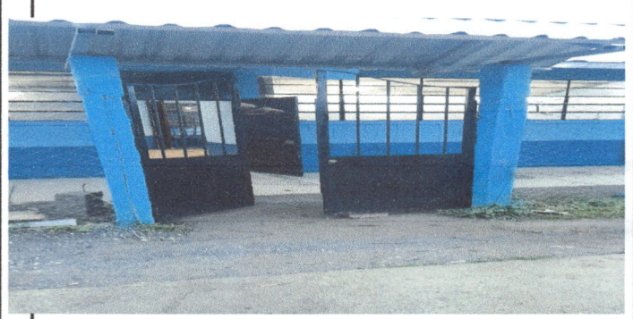
Foto 2: Cambio de porton de madera a metal
