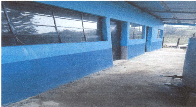
Foto1: cambio de techo por Galvanizada a lamina troquelada
